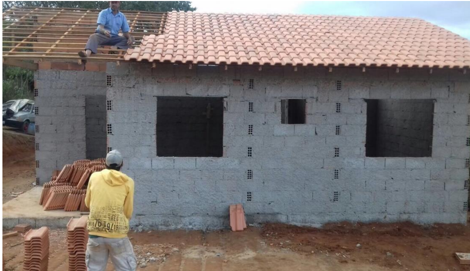
Figuras 06, 07 e 08 – residências em construção no assentamento Franqueza e Realeza através do PNHR
